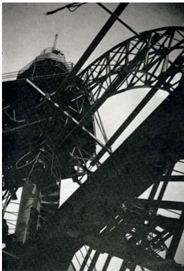
Henri Rivière: La Tour Eiffel en construction, 1888/89, 11,8 x 8,2 cm (aus: Françoise Heilbrun, Philippe Néagu, Meisterwerke der Photographie im Musée d'Orsay , Stuttgart: Klett-Cotta, 1987, Taf. 173)
